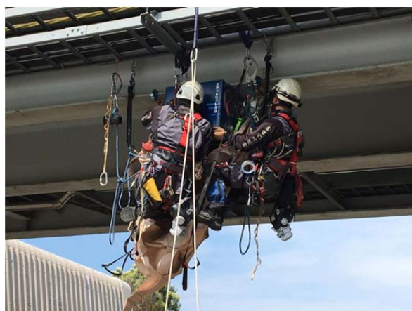
写真一下地処理の状況
