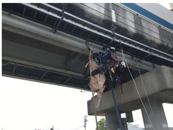
写真一特殊高所技術者による作業状況
