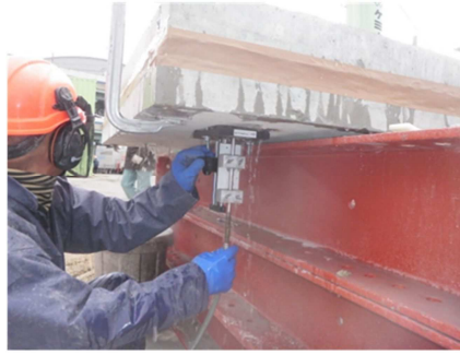
写真—1 洗浄状況
