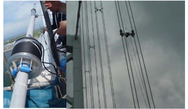
写真 ケーブル調査実施例
