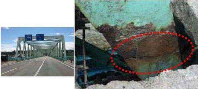
写真－損傷事例
