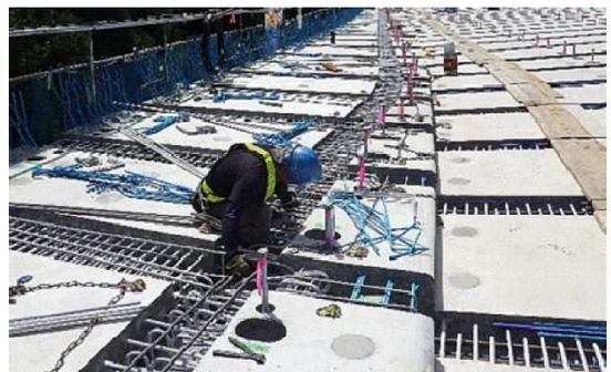
写真－PC床版への取替え工事
