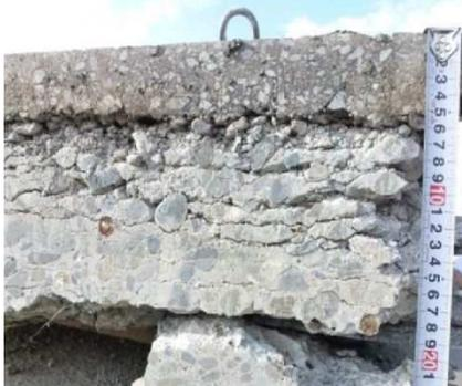
図－RC床版の劣化事例
