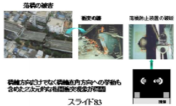
(スライド83) 地震に関していえば、兵庫県南部地震が桁どうしが衝突して橋が使えなくなった例がかなりありました。衝突のモデル化を目的に研究室の中で実験をやると、衝突現象でどうやって計測するかというのが出てきます。
