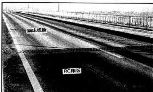
結露凍結(鋼床版橋VS鉄筋コンクリート床版)
