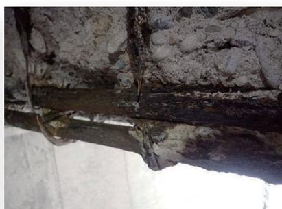
鉄筋露出部のコンクリートをはつり、腐食した鉄筋を撤去する
