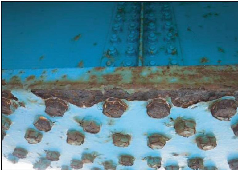
下向きのボルトや座金の角は塗膜が薄くなって錆び易いので、雨水や結露水が滴になって濡れ時間が長くなるんだよ。
