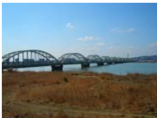
伊勢大橋全景
