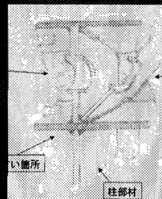
図-3: ラーメン橋脚隅角部割れの状況 (多数の溶接継ぎ目によるコーナー部(溶接なし)に亀裂が発生)
