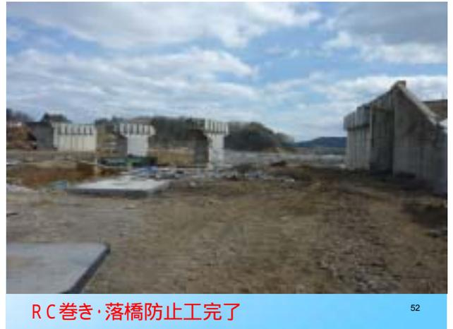
橋台背面流失・応急復旧(迂回路整備)
