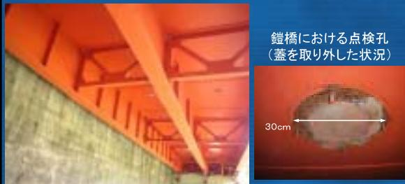
・伸縮装置からの漏水による発錆が一部に見られたが、全体的に良好な状態
