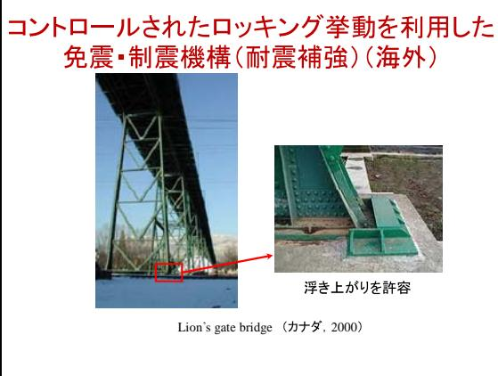
**コントロールされたロッキング型制震・免震機構の上路式鋼アーチ橋への適用**
