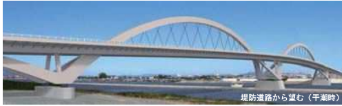
堤防道路から望む（干潮時）
