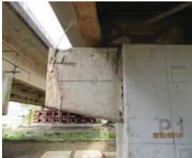
P1橋脚(下り線)中分側
