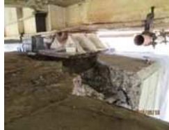
P1橋脚(上り線)梁天端
