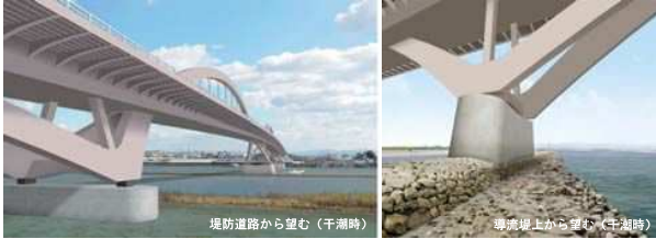
堤防道路から望む（干潮時）
